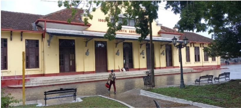
ESTAÇÃO FERROVIÁRIA: mais um legado de Marta Abreu, o terminal ferroviário, datado de 1860, ainda em pleno funcionamento
